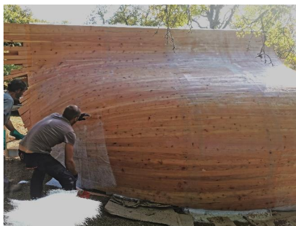
Insertion de la "peau" de fibre de verre avant fixation des coquilles
